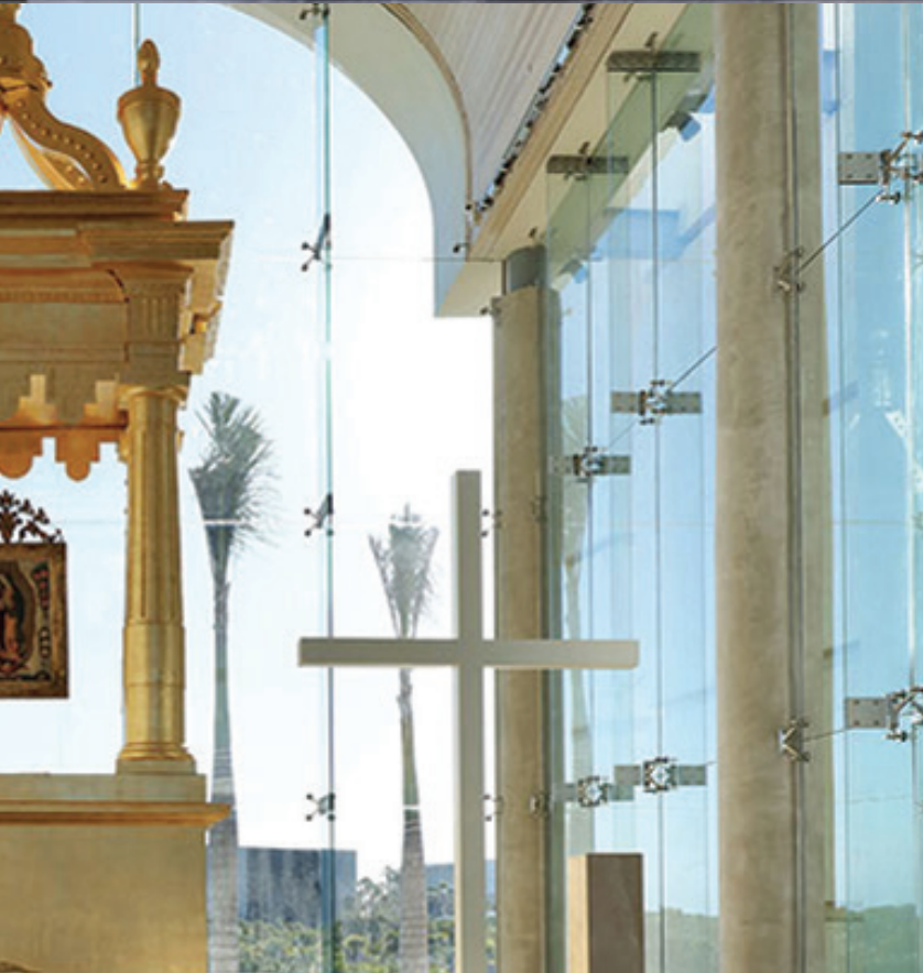
SISTEMA DE COSTILLAS HOTEL PALLADIUM COSTA MUJERES Instalado por: Interlum
